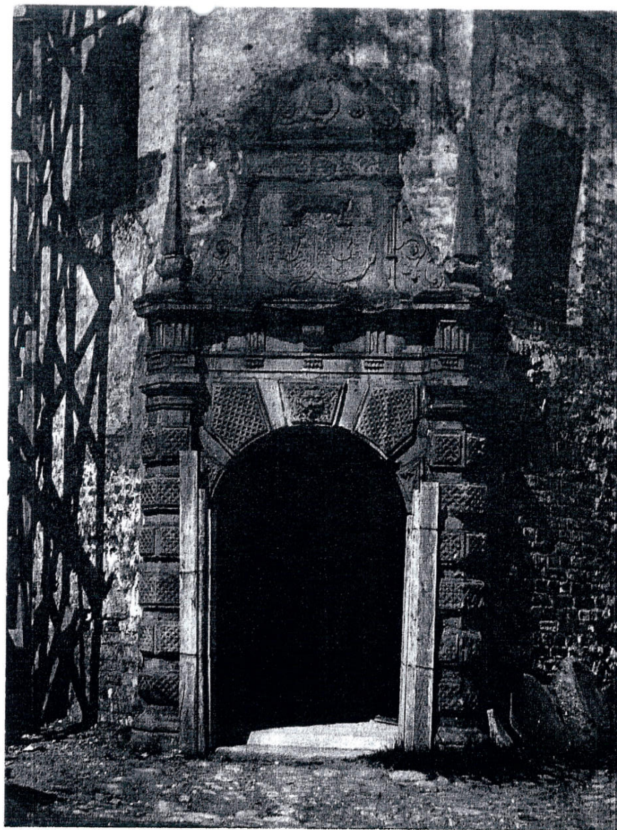
Figur 3. Ca 1931. Næsten uændret tilstand. En skade er i udvikling nederst i højre skjold. Beskyttelsesbrædder bekræfter risici for fysiske skader under reparationer. Nr 240 i Norns album.
