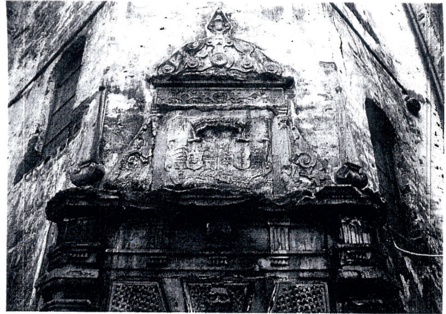
Figur 7. 1992. Detalje af Trompetertårnets portal efter fjernelse af den provisoriske beskyttelse. Portalen fremtræder ren og fri for fugt og vækster. Foto: 71.61.54. J.Ex.
