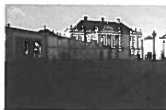
Amalienborg, set mod Harsdorffs kolonnade, der med en gangforbindelse indbygget øverst forbinder Schacks og Moltkes Palæer. Man aner næppe, at de forhøjede trefags mellembygninger mellem palæer og hjørnepavilloner har givet slotspladsen en mere tillukket karakter. Foto: 2004.
