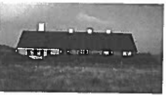
Stedets hårde klima med pres af vand gennem murværk og hurtigt rustende tagplader medførte 1988 en ny beklædning af rustfri stålplader på tage og særligt udsatte facadepartier. Foto 2001.
