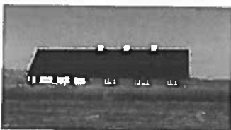
Nødvendige reparationer og renoveringer, bl.a. udskiftning af tagbeklædningen fra cementtagsten til tjærede pandeplader, prægede bygningens identitet. Foto 1965.
