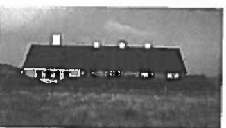
Stedets hårde klima med pres af vand gennem murværk og hurtigt rustende tagplader medførte 1988 en ny beklædning af rustfri stålpladeplader på tage og særligt udsatte facadepartier. Foto 2001.
